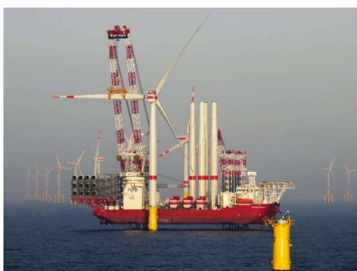
WTIV：洋上風力発電設備設置船 (SEP 船)
